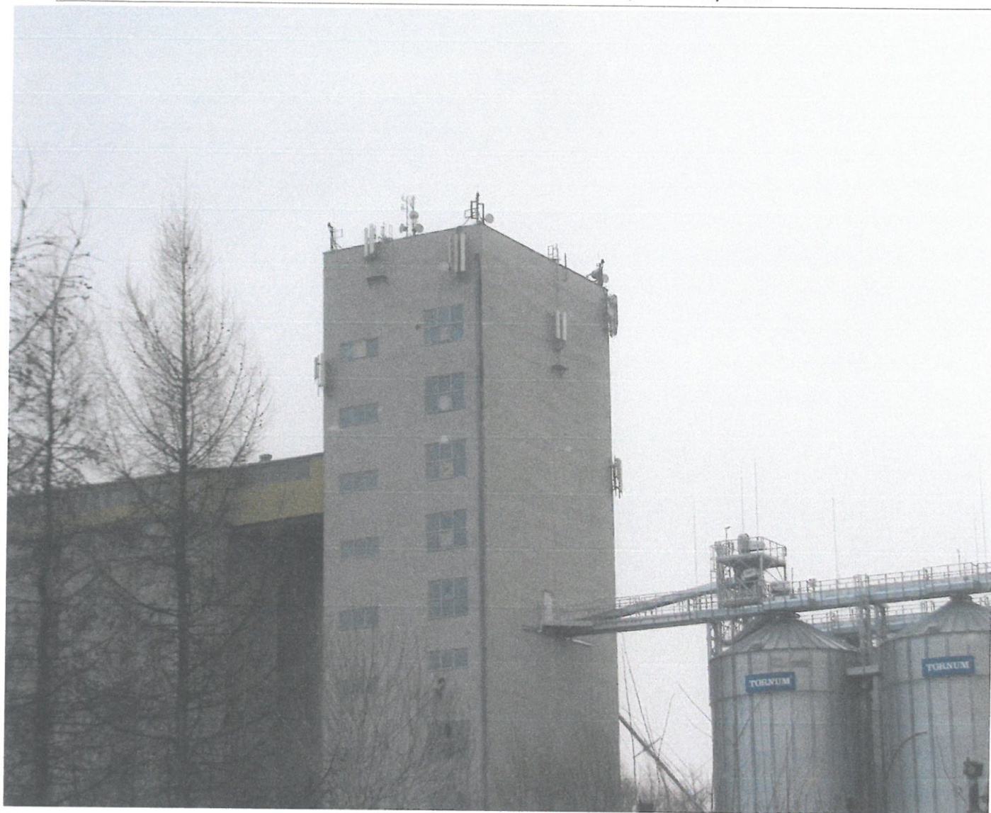
Zał. nr 1: Widok ogólny instalacji radiokomunikacyjnej.
